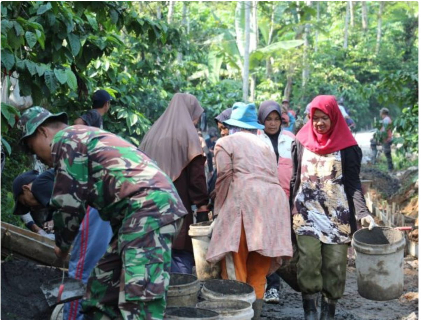
Ibu Ibu Bantu Percepat Pembangunan TMMD
